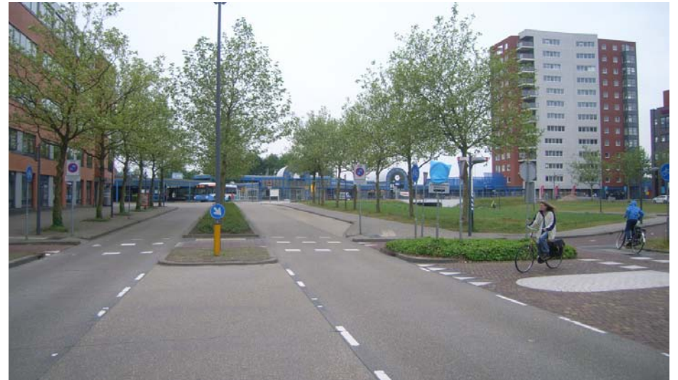
Doodlopende route KR Poststraat op station
