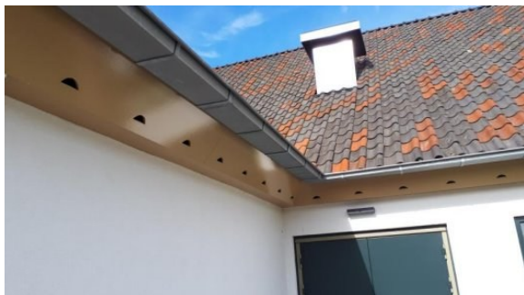
Figuur 11 Voorbeeld maatwerk onder dakrand, als natuurinclusieve voorziening voor vogels. Foto: NatuurInclusief Ecologisch advies en projectbureau
