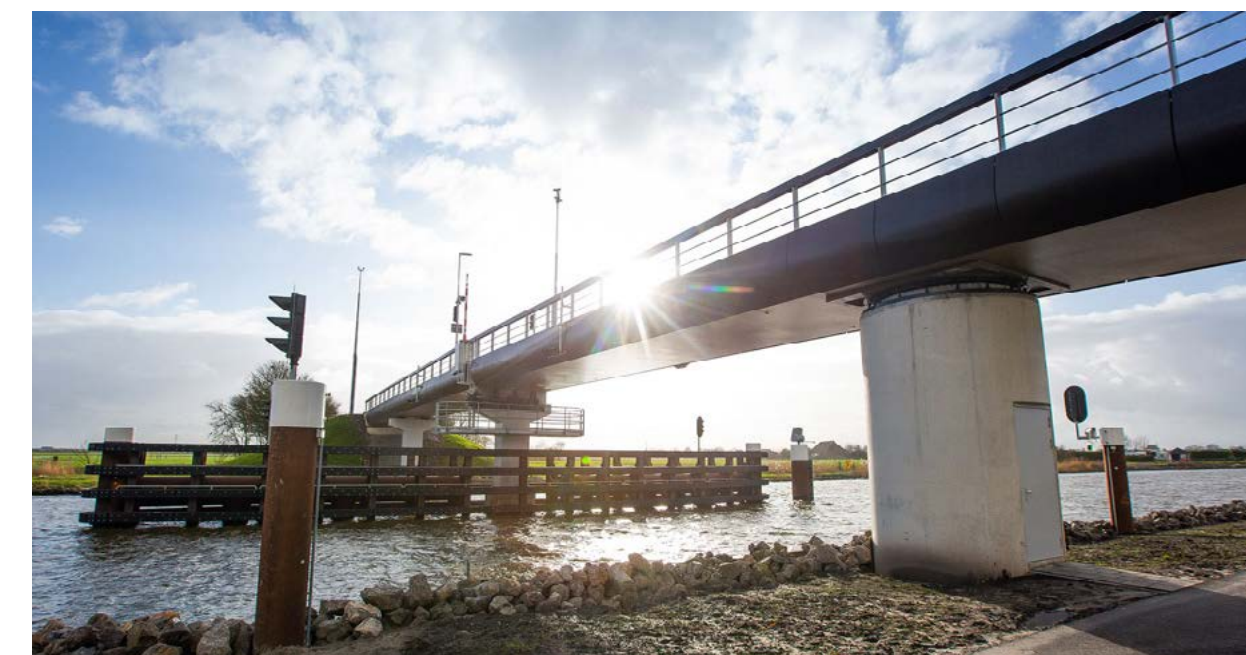
Figuur 4.3: Biocomposiet fietsbrug Ritsumasyl
