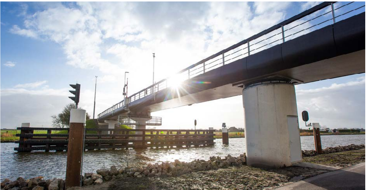
Figuur 4.3: Biocomposiet fietsbrug Ritsumasy
