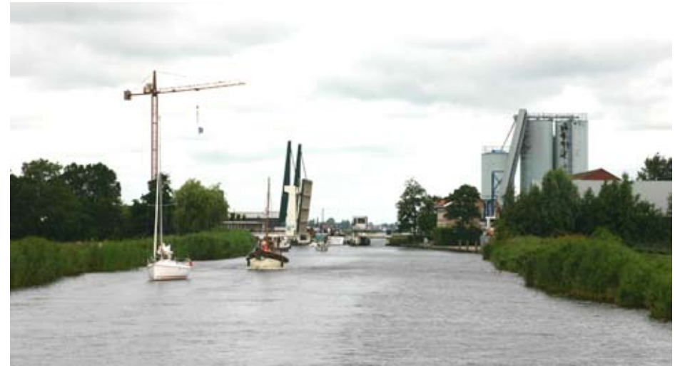
de brug bij Osingahuizen vanaf het water
