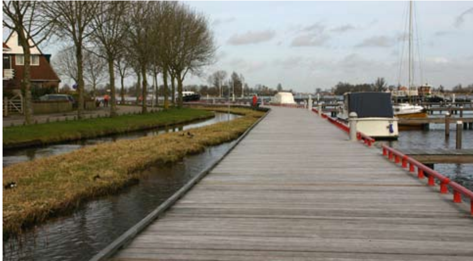
Grou: wandelsteiger bij de passantenhaven
