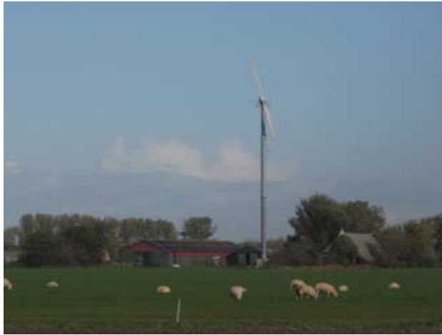
turbine op het boerenerf, type Lagerwey
