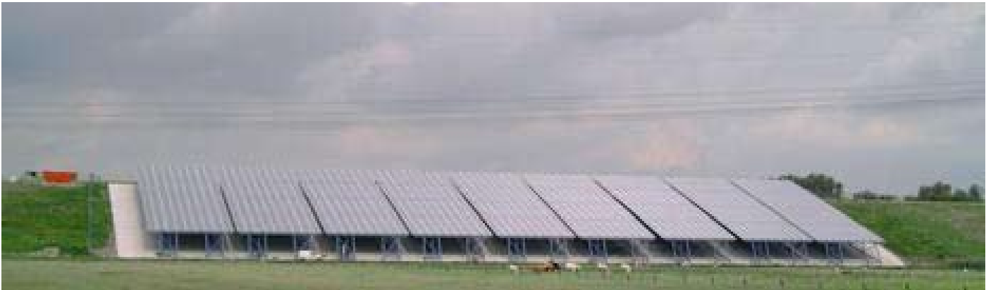
Eco-park Waalwijk op voormalige vuilstort
