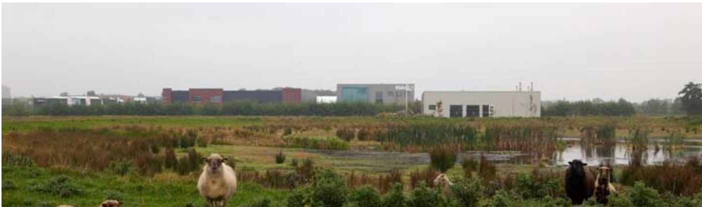
Bedrijventerrein Azeven-noord te Drachten, platte daken (Fotografie: I See For You)
