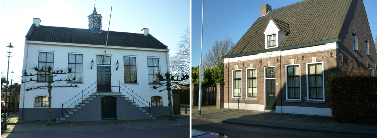
Het historische raadhuis en tegenoverliggend woonhuis
