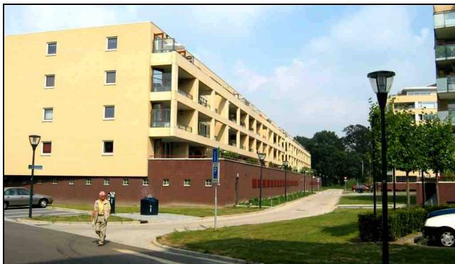
Geldrop, woningbouw aan de Meent
