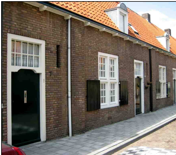
Woningbouw met Delftschool details
