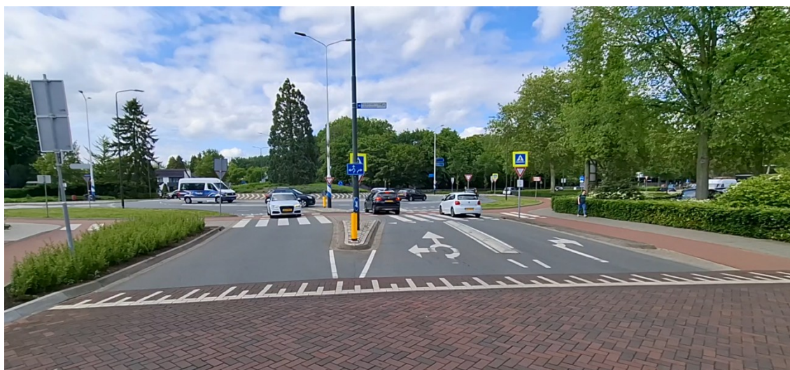
Foto 13 – Turborotonde gezien vanuit de Nieuwendijk (zuid) met een abrupte overgang van de verharding
