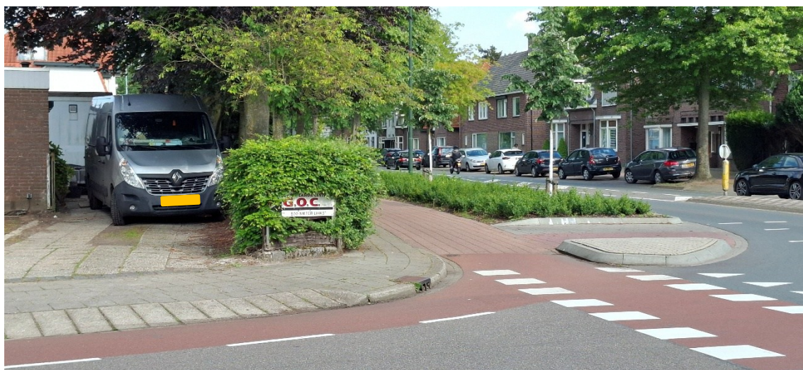
Foto 21 – Het zicht naar links op fietsers waaraan voorrang verleend moet worden wordt ontnomen door de heg
