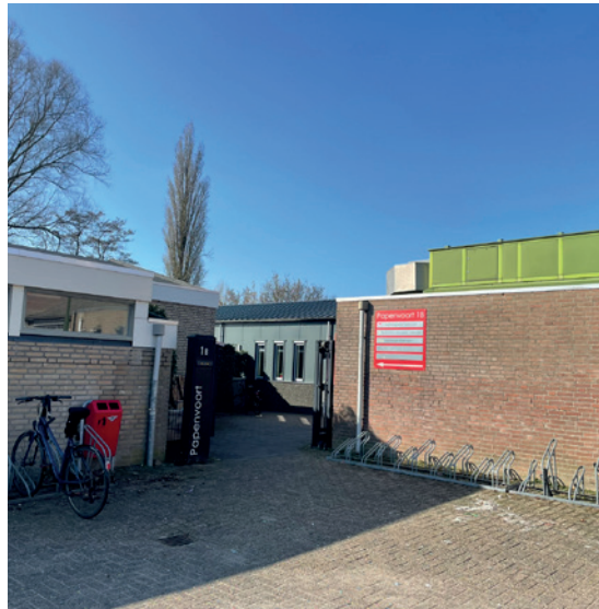
Ingangen van de voorzieningen weinig leesbaar
