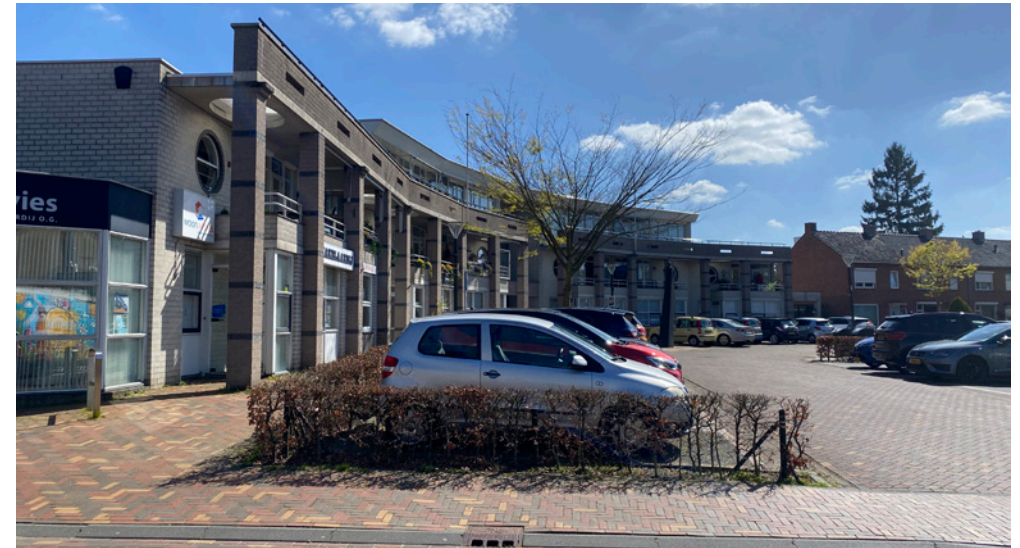
Aanleg Margrietstraat '80 en vervangende nieuwbouw '90
