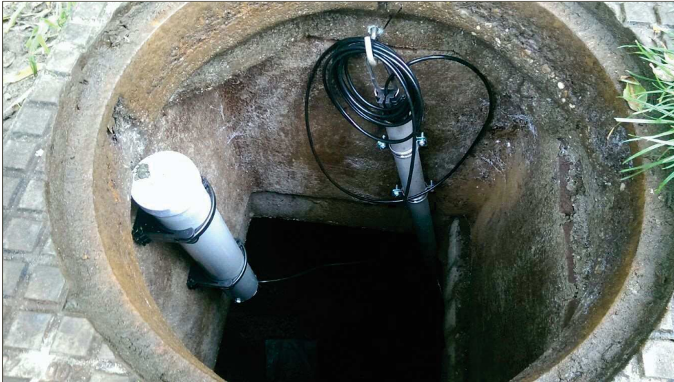
Afbeelding 5 Metingen in het rioelstelsel worden uitgevoerd.
