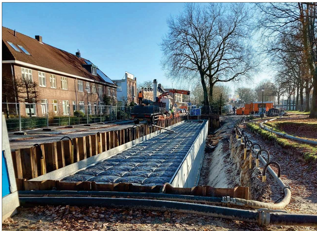
Afbeelding 10 Aanleg ondergrondse waterberging Parallelweg
