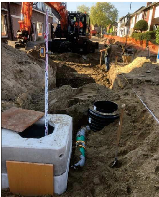
Abbeelding 15 Vervanging van riolering
