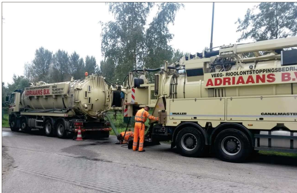
Afbeelding 14 Uitvoering van riolreiniging
