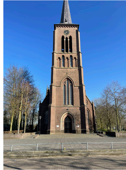
vele paaltjes, elementen en verharding geven verrommeld beeld
