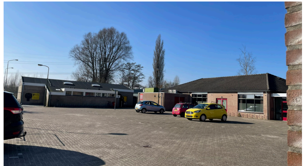
... of achteraf gelegen volledig verhard en uit het zicht
