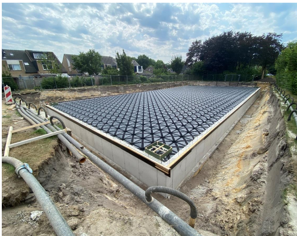
Figuur 3 Aanleg waterberging Wersakker (bron: Waterblock b.v.)
