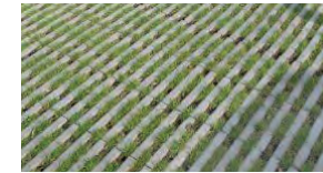
Rijbaan bussluis Grasbetonsteen Halfsteensverband Hydro Lineo 40 Struyk Verwo
