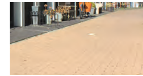
Woonstraten en voetpaden: Betonstraatsteen 10,5x21 Keifmaat, Keperverband Keranova Ocra Struyk Verwo
