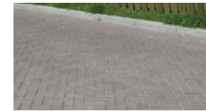
Hoofdontsluiting: Betonstraatsteen 10,5x21 Keiformaat, Keperverband Baleno 350 Struyk Verwo
