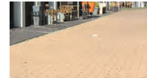
Woonstraten: Betonstraatsteen 10,5x21 Keiformaat, Keperverband Keranova Ocra Struyk Verwo
