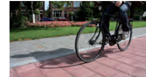
Fietspaden: Betontegel 30x30, Rood Halfsteensverband Struyk Verwo
