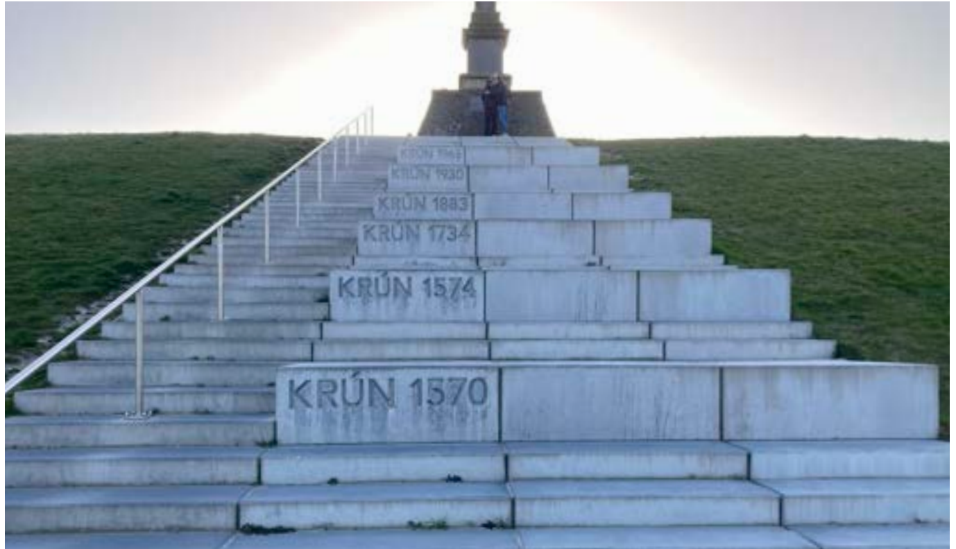
Evolutie van de hoogte van de Westerzeedijk ten zuiden van Harlingen. Trappen ontworpen door Strootman Landschapsarchitecten
