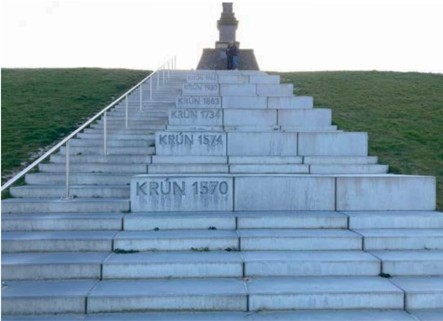
Figuur 8: Evolutie van de hoogte van de Westerzeedijk ten zuiden van Harlingen. Trappen ontworpen door Strootman Landschapsarchitecten
