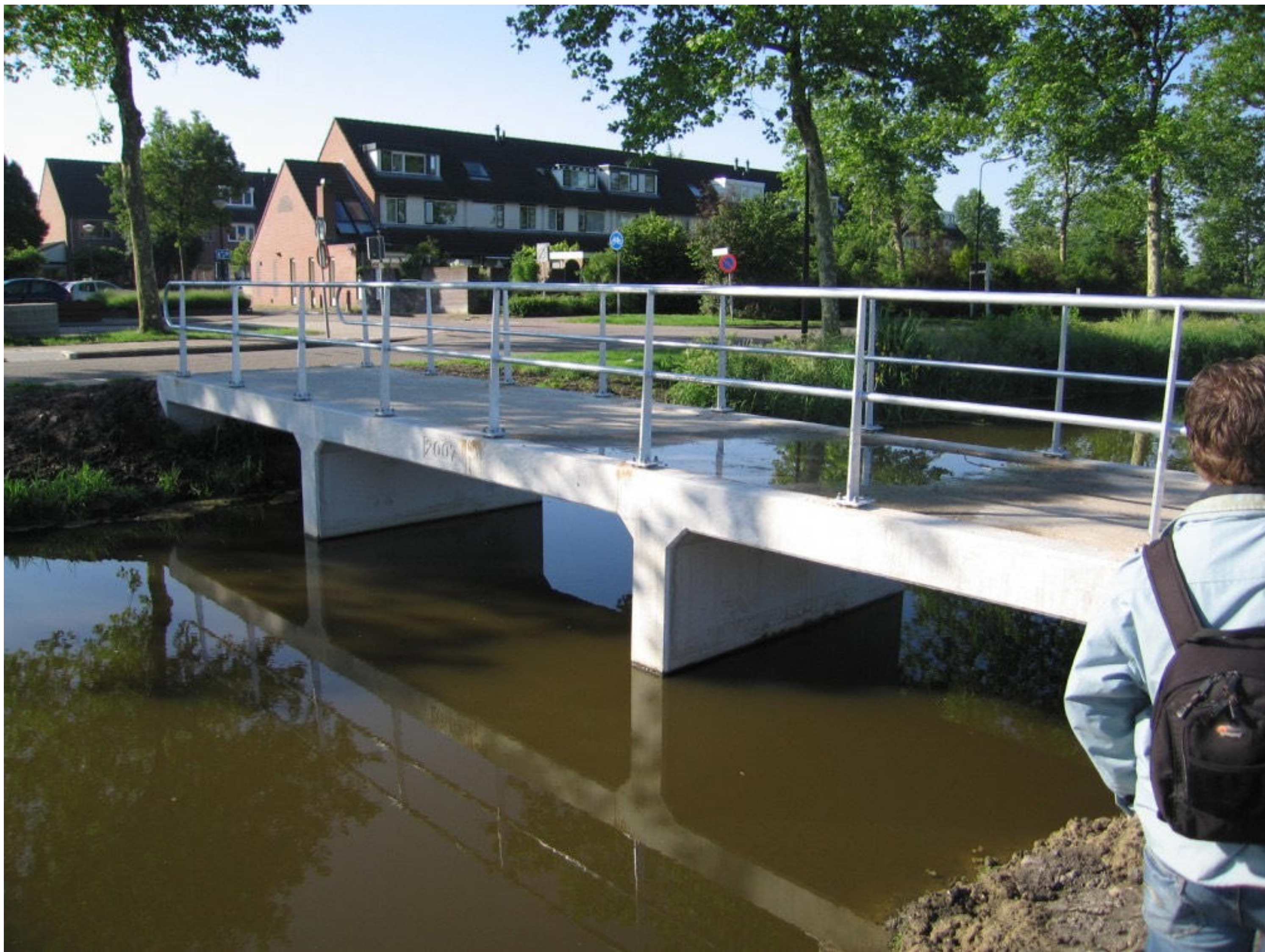
voorbeeld bruggen beton met eenvoudig hekwerk
