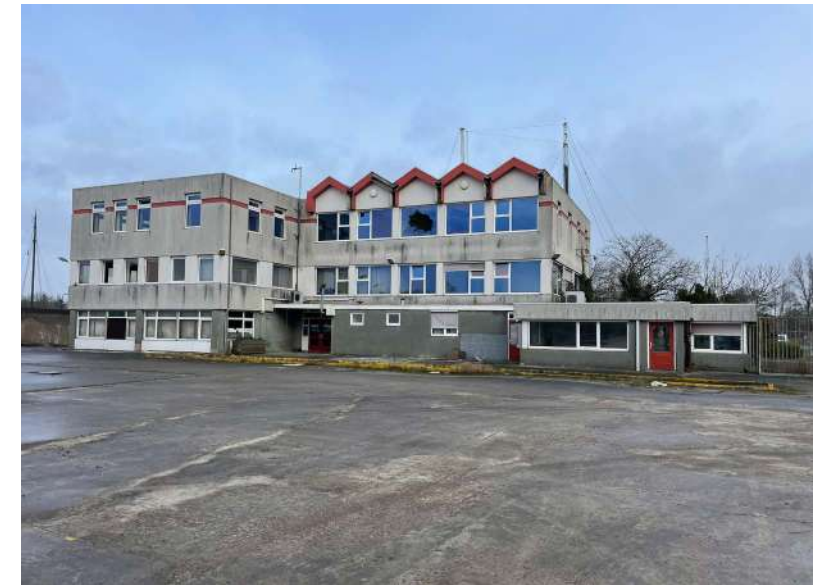
Kantoor is gesloopt per 15-07-2024
