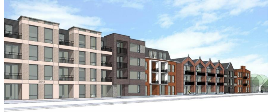
▲ Locatie Dukdalf aan de rand van de binnenstad, met uitzicht enerzijds op de Zuiderhaven en anderzijds over de Waddenzee, is een goed voorbeeld van een aantrekkelijke woonplek op een goede locatie. Ontwerp: Penta Architecten.
