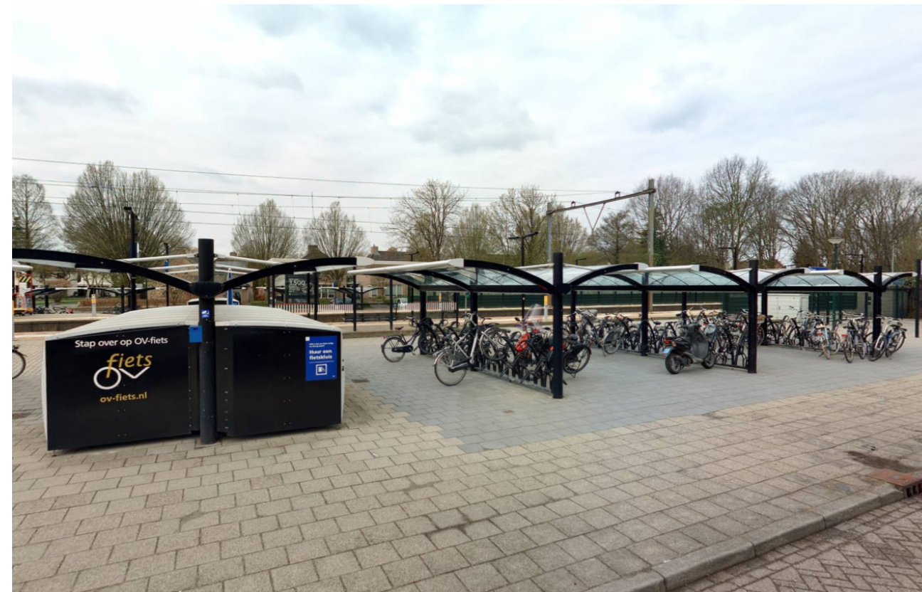
Fietsenstalling station Heeze
