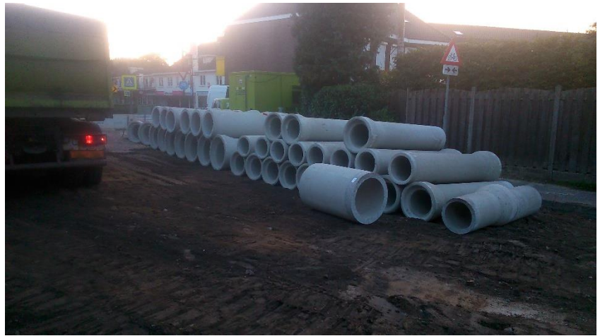
Figuur 20: Aanleg riolering Stationstraat in Heeze
