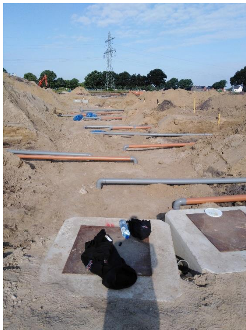
Figuur 10: Aanleg huisuitleggers De Bulders
