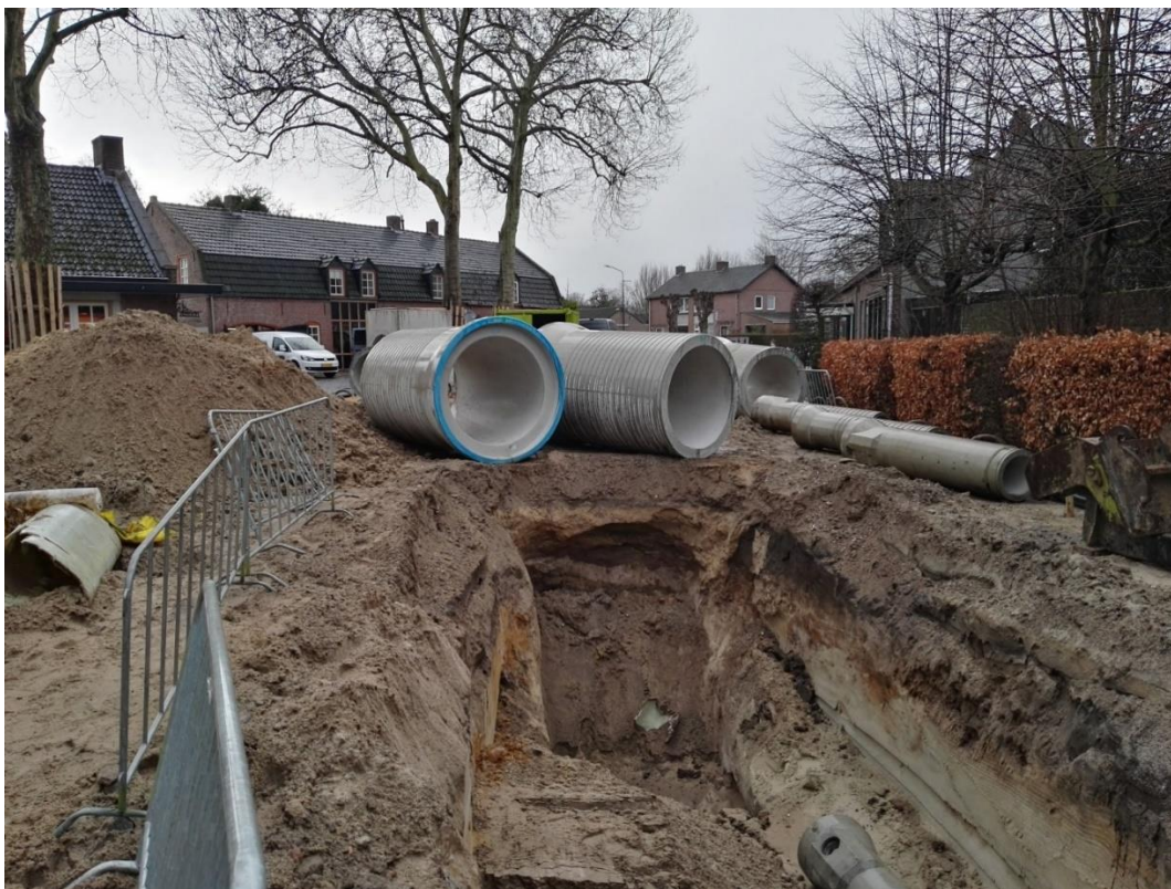
Figuur 8: Aanleg riolering Oosterikkerstraat in Leende
