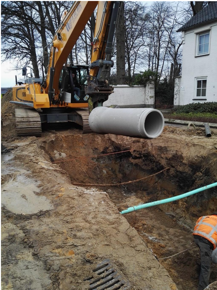
Figuur 21: Aanleg riolering Spoorlaan Schoolstraat
