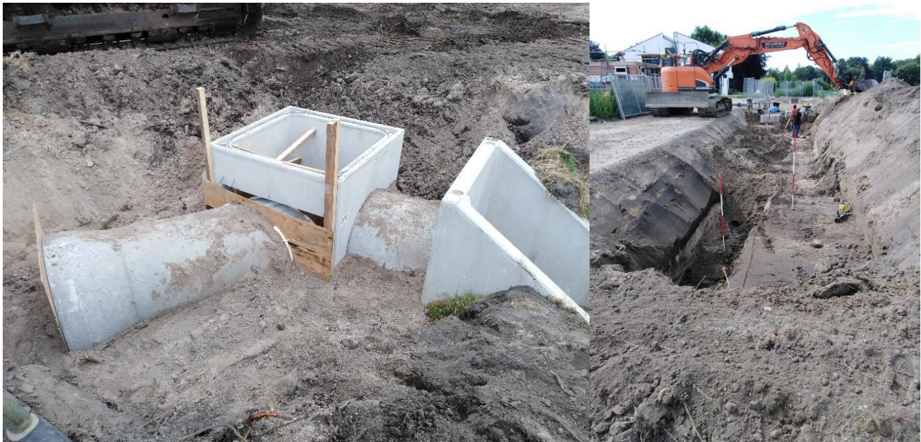
Figuur 12: Aanleg riolering De Bulders
