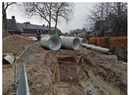
Figuur 6: Realisatie riolering Oostrikkerstraat
