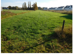
Foto 4.3 | Open ontgraving door weiland vanaf mast 114
