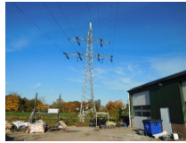
Foto 4.2 | Mast 114 vanaf de weg Ringgreppel Kruis
