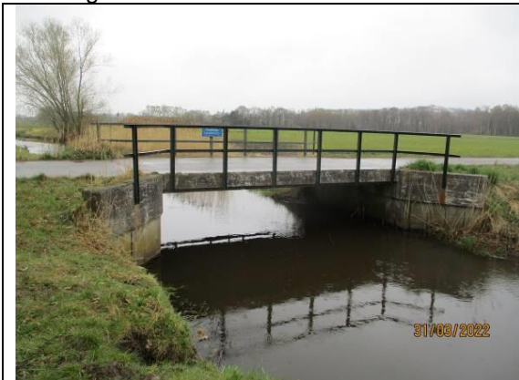
Betonnen brug (27 stuks)
