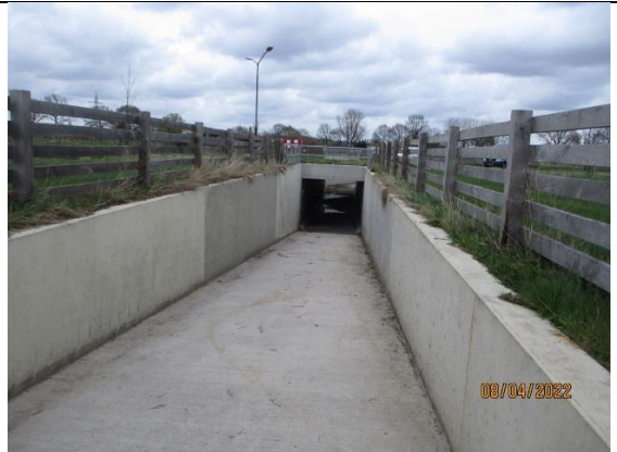
Tunnel 32: Locatie Randweg Heeze
