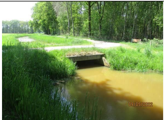
Betonnen duikerbrug (1 stuks)
