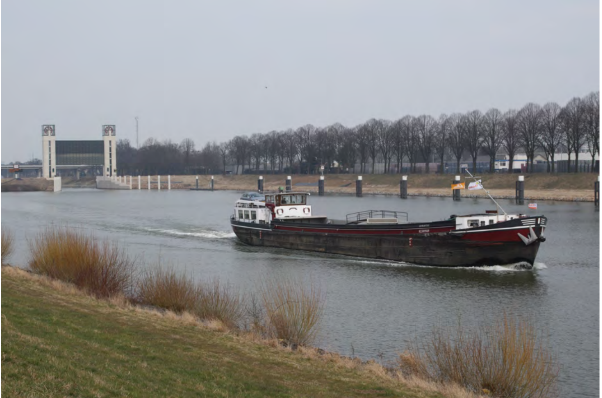
Het Maas-Waalkanaal met op de achtergrond de nieuwe keersluis bij Heumen.
