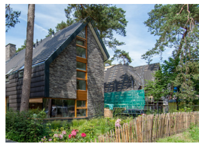
Terughoudend kleurgebruik, eenvoudige vormtaal, accent bij gevelopeningen
