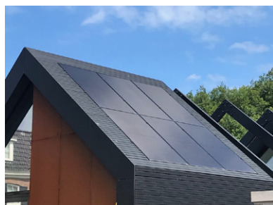
Geïntegreerde pv-panelen binnen dakvlak
