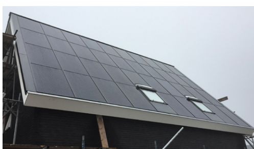
PV-panelen als dakvlak
