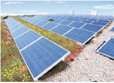
PV-panelen met sedum op platte daken
