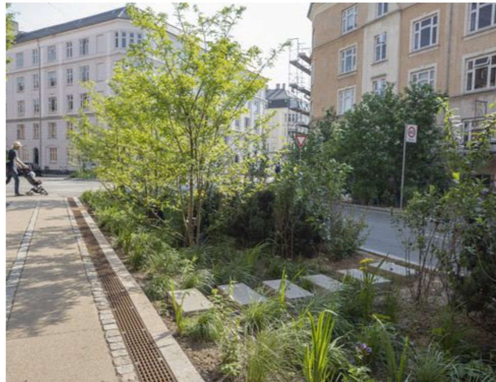
Waterinfiltratie door wadi
