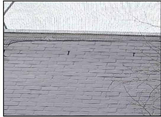
Afbeelding 12: Geschikte verblijfplaats vlermuizen in de directe omgeving.
