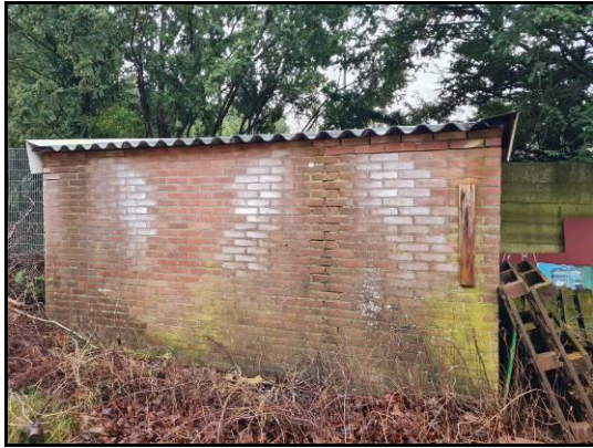
Afbeelding 11: Geschikte zomer-of paarverblijfplaats gebouwbewonende vlermuizen.
