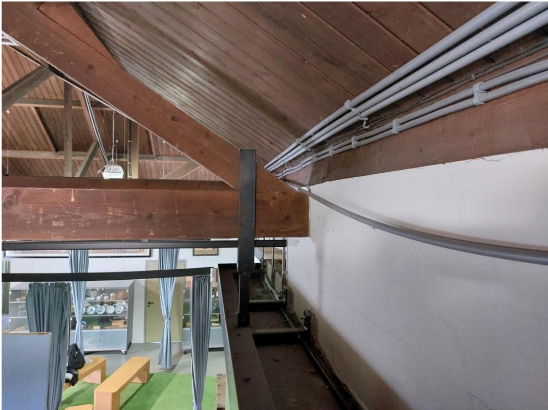
afb. 2-3: aansluiting spantconstructie tpv de schuifdeuren. In het midden is de bovenzijde van de koof van de glazen schuifdeuren/ glazen voorzetwand te zien.
