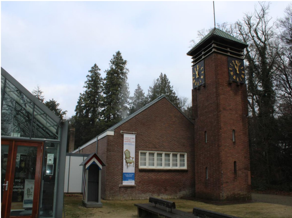
afb. 2-1: zuid-westhoek van de Garage. Rechts de Klokkentoren, links de Kas.
