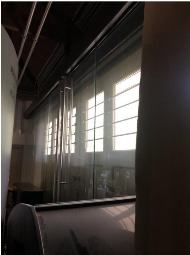
afb. 2-4 en 2-5: detail glazen voorzetwand tpv de schuivende deuren. In de glazen voorzetwand zijn schuivende glazen deuren opgenomen.
