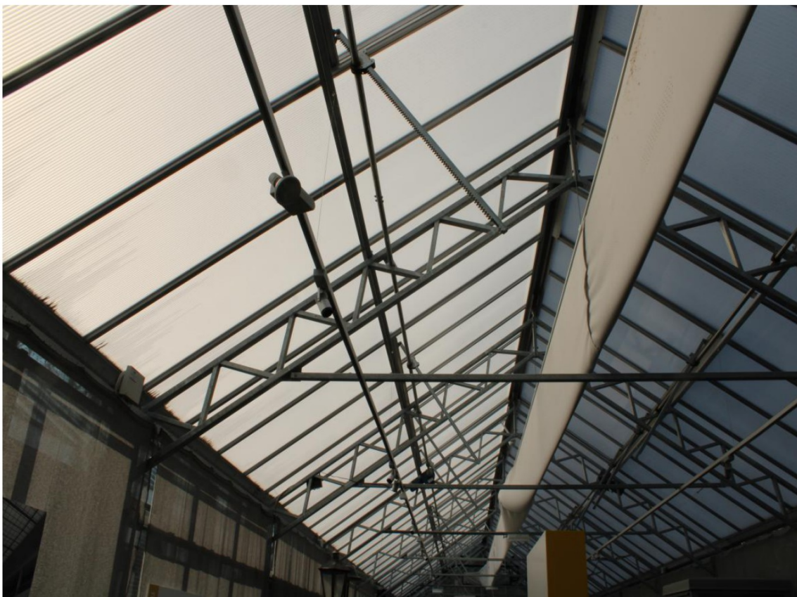
afb. 2-2: detail spantconstructie
