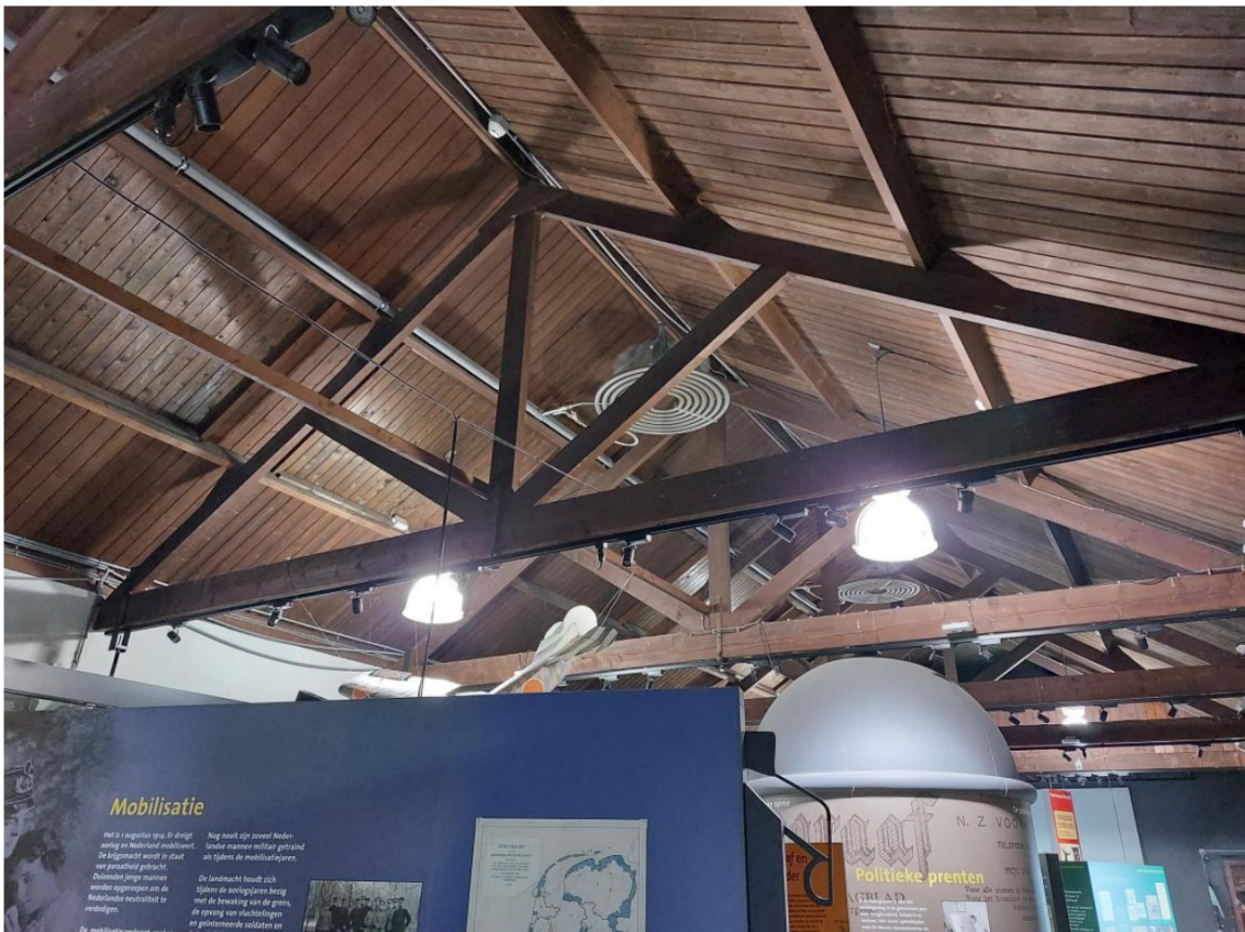
afb. 2-2: detail spantconstructie. Vanwege de getoonde expositie is het moeilijk een goed beeld te geven van het interieur.
