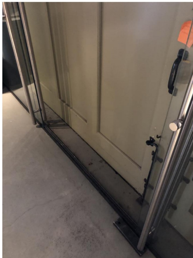
afb. 2-4 en 2-5: detail glazen voorzetwand tpv de schuivende deuren. In de glazen voorzetwand zijn schuivende glazen deuren opgenomen.
