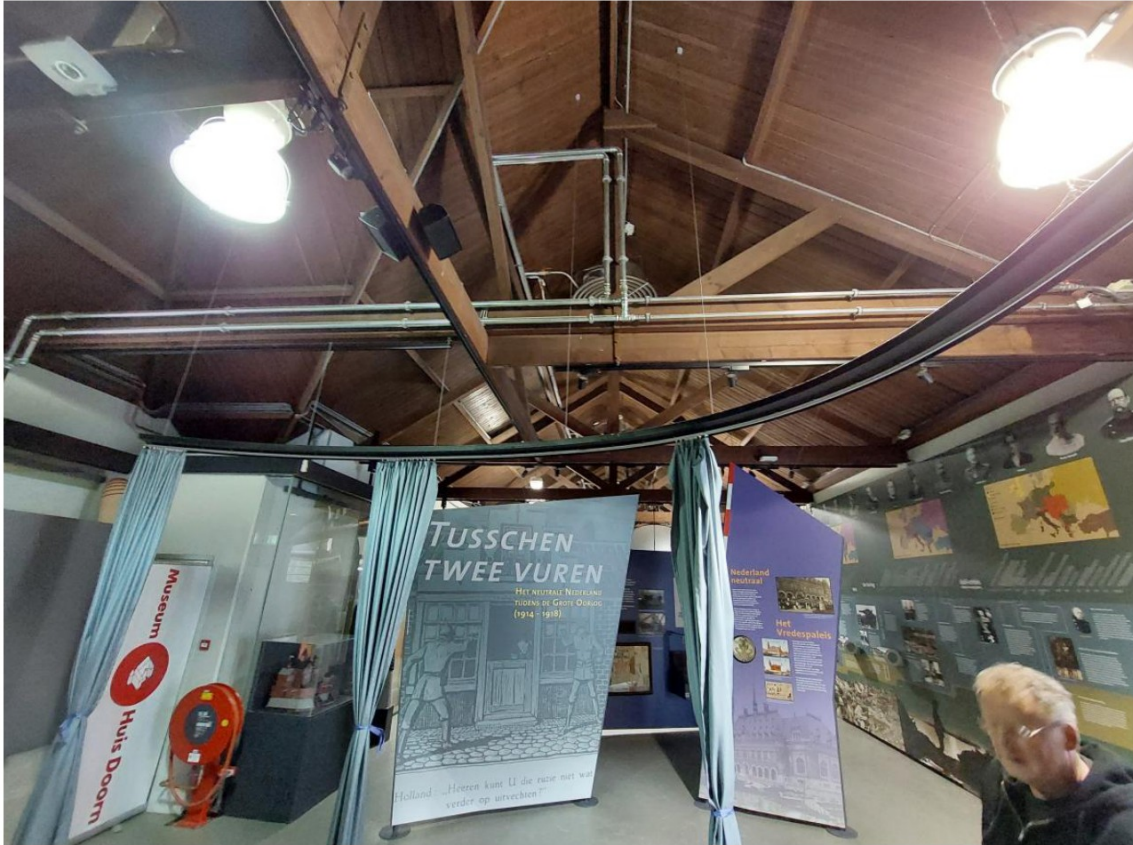
afb. 2-1: interieur garage. Rechts is een voor de wand een paneel geplaatst met informatie-visuals.
