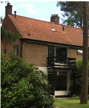
Balkon 'op poten' (Kapelweg)
