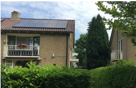
Verdiept liggend balkon en aan gevel hangend balkon (Kapelweg)
