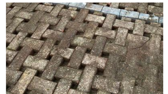
hergebruik bestaande klinkers in open structuur
