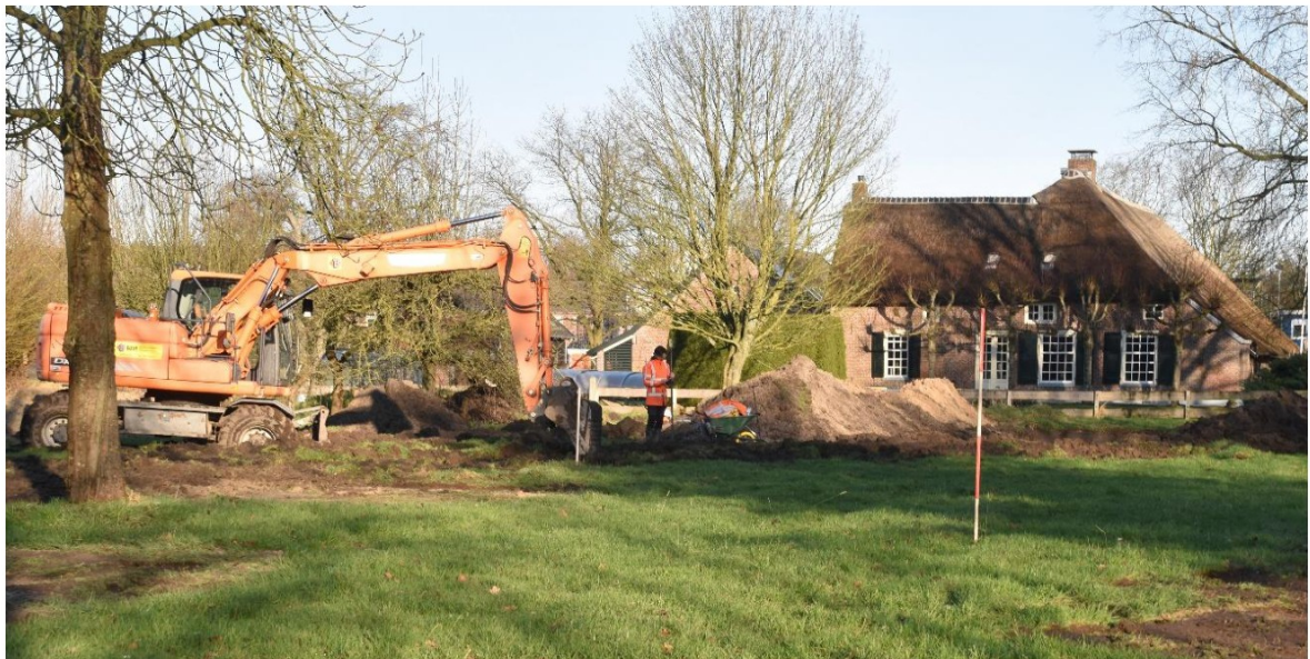
Afbeelding 4: Werkzaamheden in het plangebied met rechts het Rijksmonument 24.066. De foto is richting het noordoosten genomen. Foto: Vestigia.
