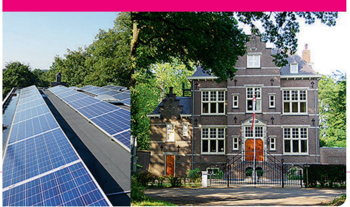
| De zonnepanelen op het platte dak van het hoofdgebouw van Broekbergen zijn vanaf de weg niet zichtbaar
