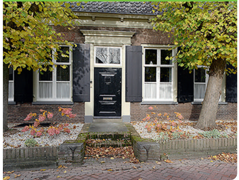
| Leilinden zorgen dat dit monument in Amerongen duurzaam wordt verkoeld
