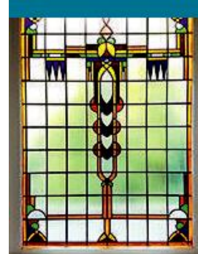
| Glas-in-lood kan door een buitenvoorzetraam beschermd worden tegen vandalisme
