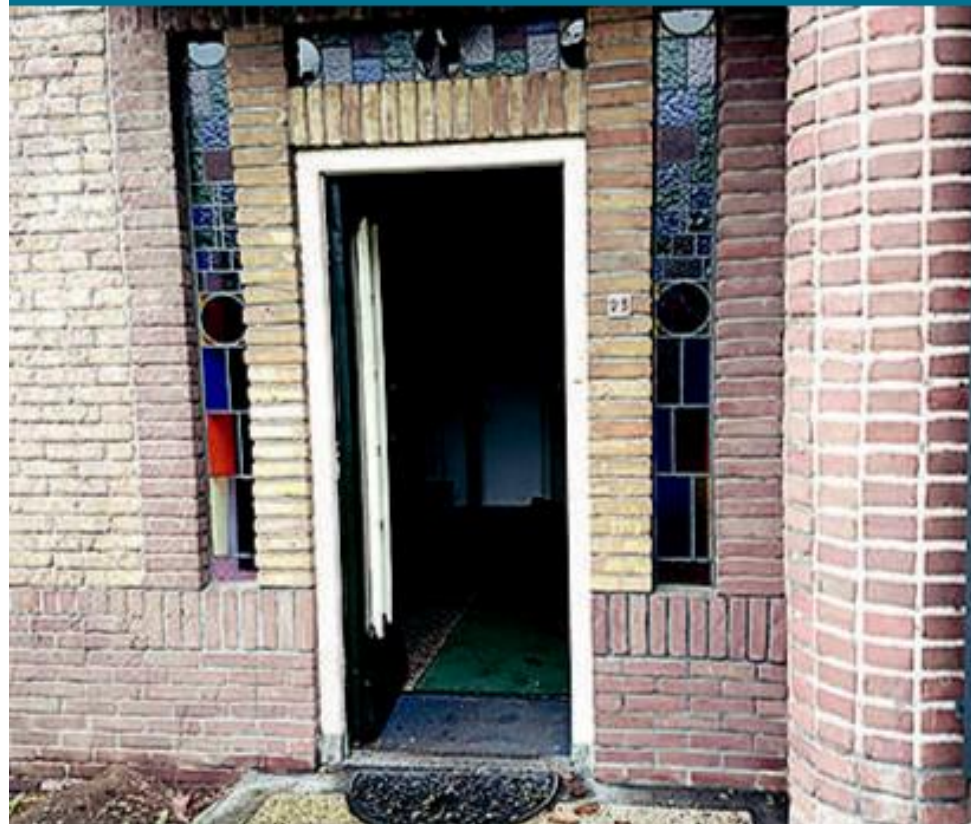
| Entree van een woonhuis in Amsterdamse School stijl met spouwmuur aan de straat Zandvoort in Amerongen
