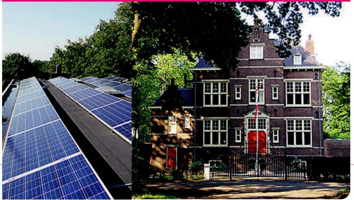
| De zonnepanelen op het platte dak van het hoofdgebouw van Broekbergen zijn vanaf de weg niet zichtbaar
