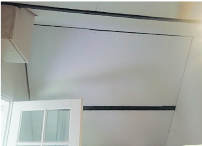
Foto onder: Nieuwe situatie met vlasisolatie en daaraan vast de MDF-plaat.
