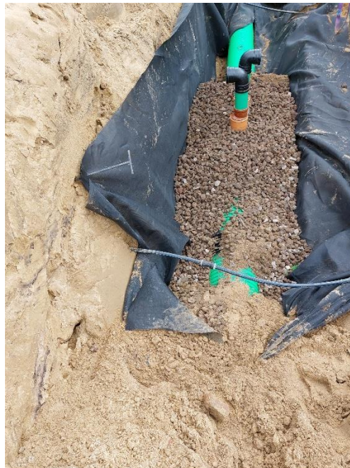
Foto's: Vuilwaterriool bruin, regenwater groen met lava omhulling voor extra watercapaciteit.
