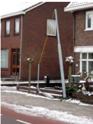
Schades aan ons verlichtingsareaal die direct gevaar opleveren
