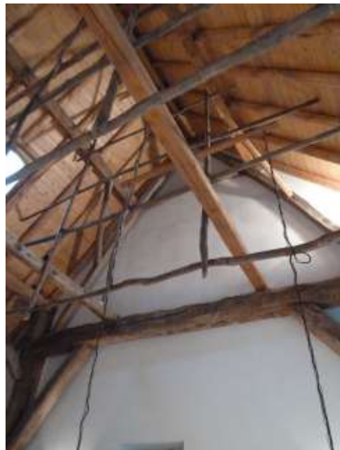
Dakisolatie wordt aangebracht tussen de daksporen en de dakpannen. Zo blijft de constructie met de sporen zichtbaar.
