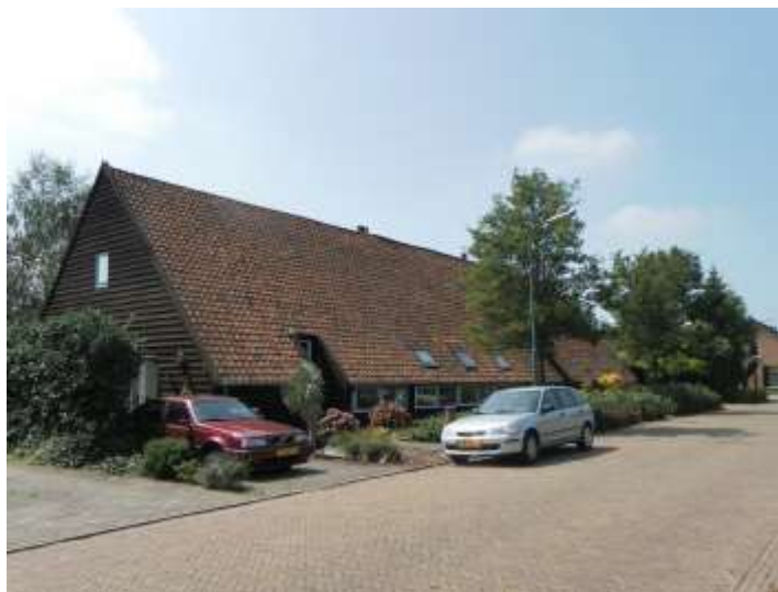
De tabaksschuur aan de De Breelaan is in 1993 verbouwd en herbestemd tot twee woningen.
