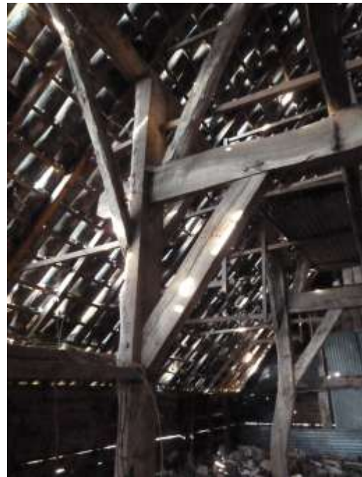
De kap van een tabaksschuur is van oorsprong onbeschoten zodat er geen regen maar wel veel ventilatie werd toegelaten.
