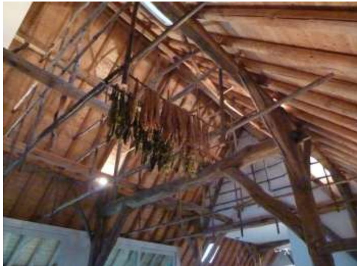
De tabaksbladeren werden te drogen gehangen aan de hanken. Deze bestonden uit horizontale ronde sparren waar de spijlen met bladeren op werden gelegd.
