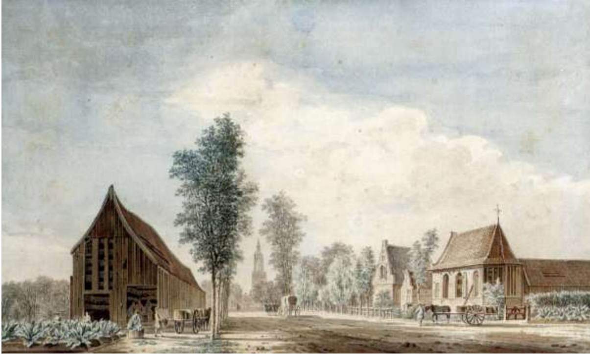
Op een tekening van Paul van Liender uit 1758 is de Hogeweg in Amersfoort te zien met links een tabaksschuur van het Amersfoortse type. De kap is asymmetrisch en de wanden bestaan uit verticaal geplaatste planken.
