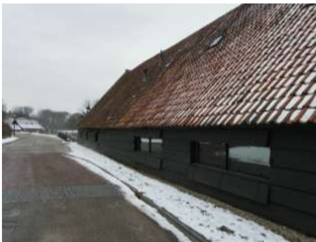
De ventilatieopeningen kunnen worden gebruikt voor lichttoevoer. Achter de kantelbare planken zijn ramen aangebracht.
