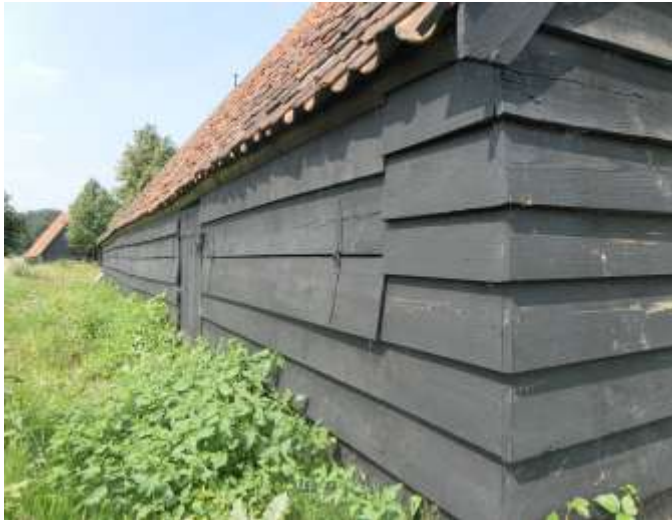
De wanden bestaan uit potdekselwerk van houten planken. Er zijn losse delen die omhooggeklapt kunnen worden voor meer ventilatie.
