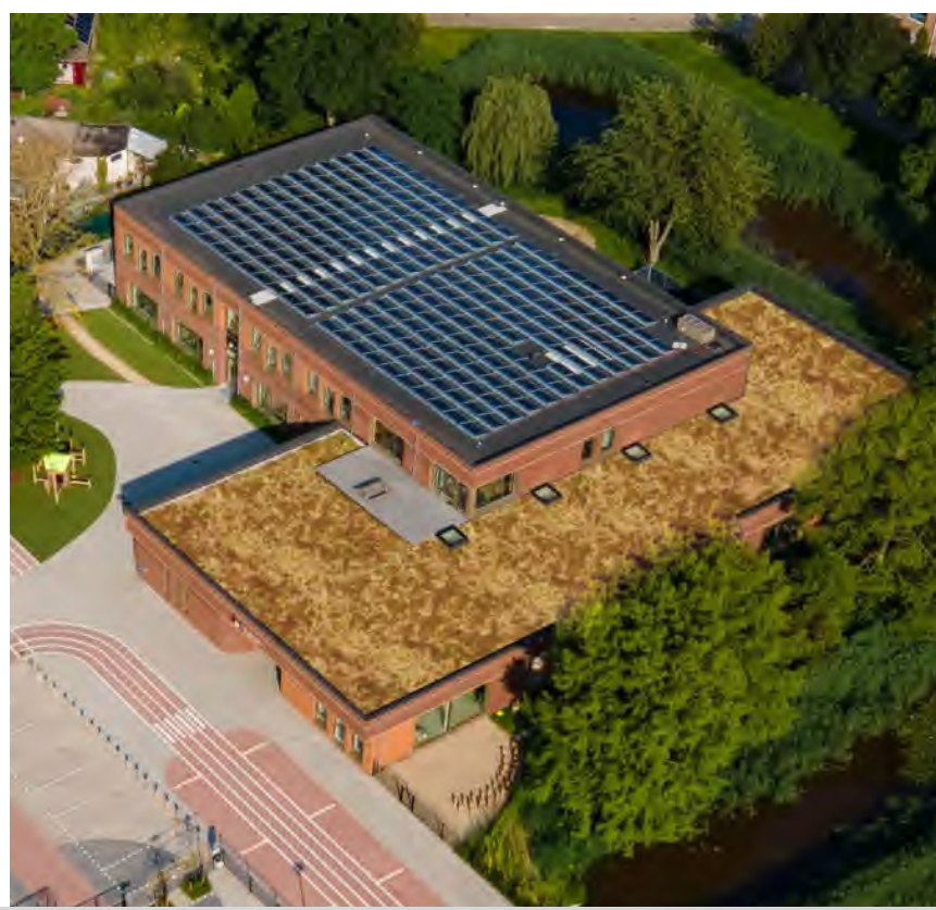
Groen dak op 1e bouwlaag, technische installaties op 2e
