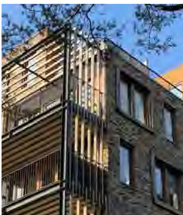
Alzijdig gebouw (plastisch) met een combinatie van inpandige en uitkragende balkons
