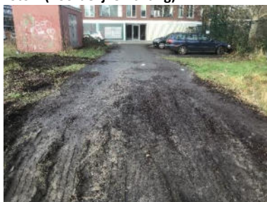
foto 7 (asfaltverharding en transformator)
