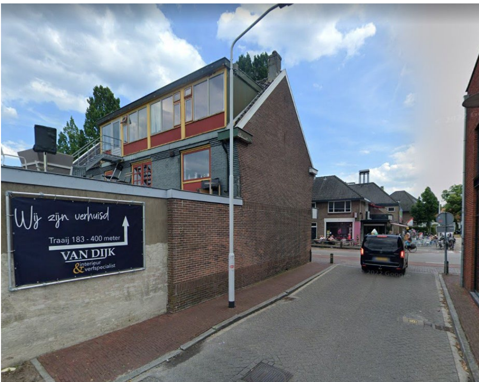
Achterzijde woon-winkelpand Traaij 127-129, gezien vanaf uitrit ten westen gelegen parkeerterrein
