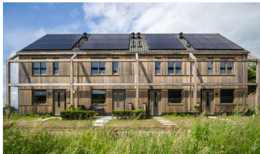
Van der Heijden bouw, www.vd-heijden.nl/projects/17-woningen-den-hoek
