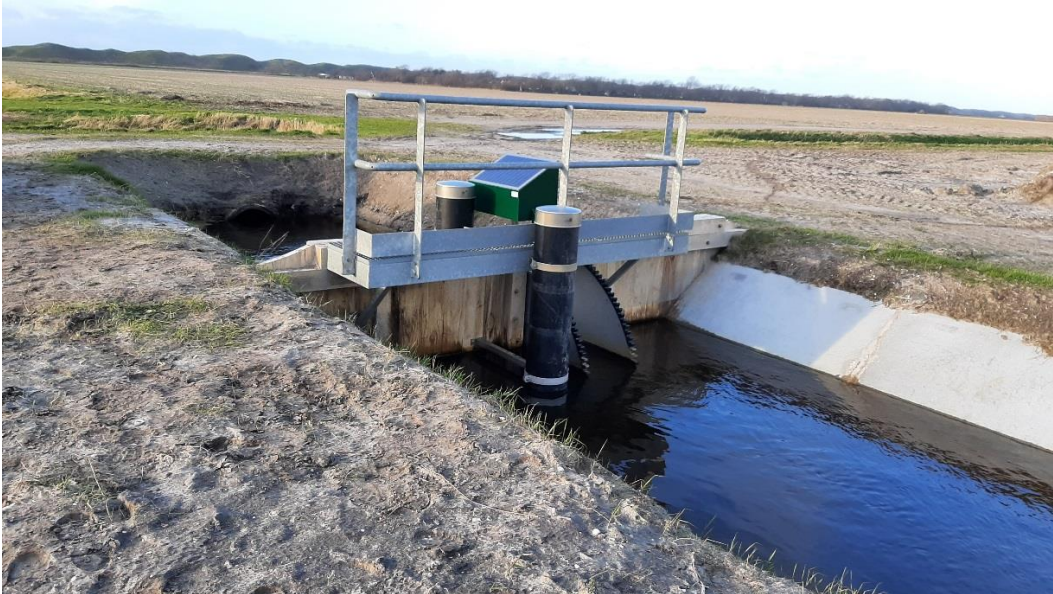
Figuur 2: voorbeeld peilregulerende stuw.
