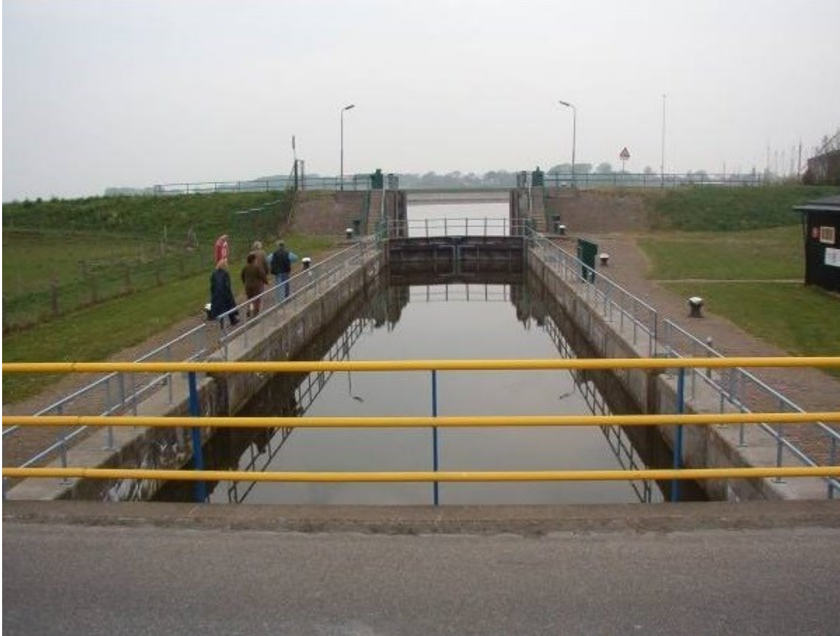
Foto: afgekeurde Haukesschutsluis
