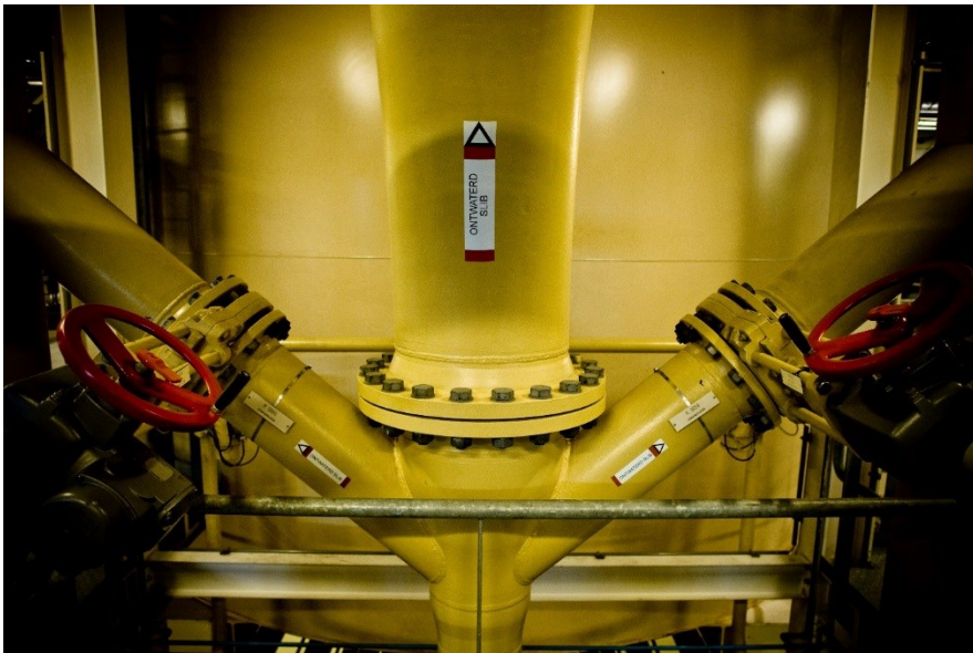
Foto: Slibdrooginstallatie (SDI)
