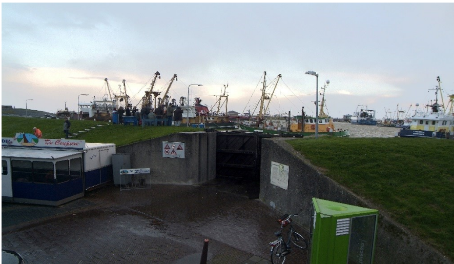
Foto: Hoogwaterkering Den Oever
