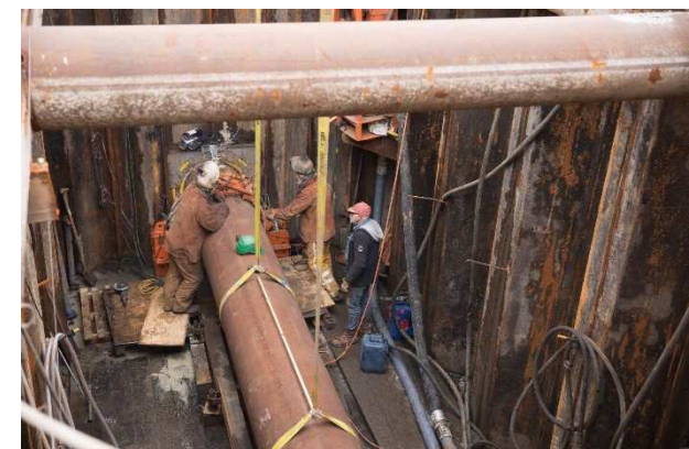
Foto: schildboring voor persleiding bij Oostzaan onder de A8
