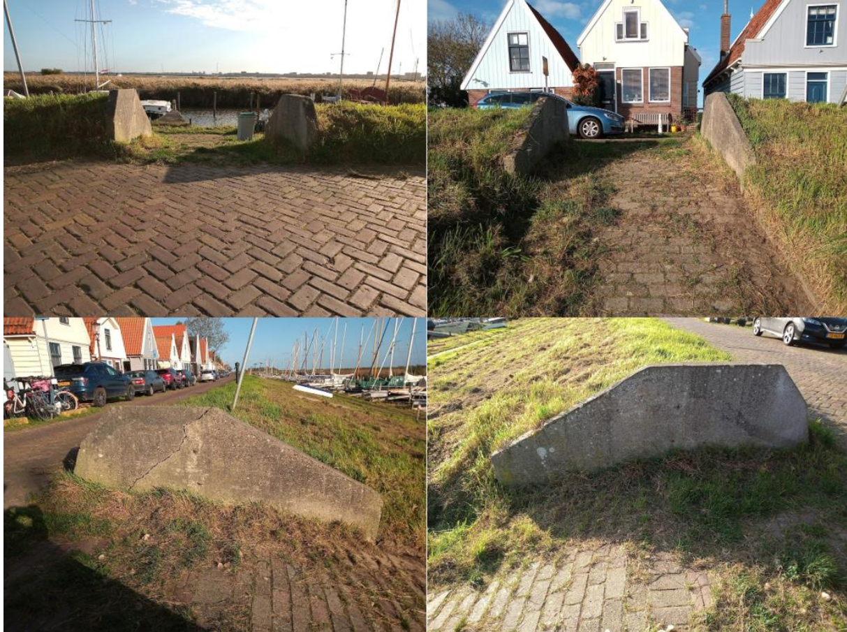
Figuur 12-2 Typisch voorbeeld van een coupure. De foto's zijn van coupure DP 154+61 en komen uit Bijlage 9 van de aanvullende onderzoeken [ref. 23]. De foto's zijn gemaakt op 01-11-2022 tijdens een veldbezoek.
