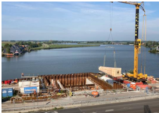
Foto 11 en 12: sep '22 houten trompetstukken worden ingehesen en geplaatst
