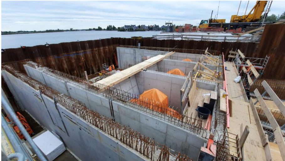
Foto 14: begin okt '22 wanden instroomzijde gestort
