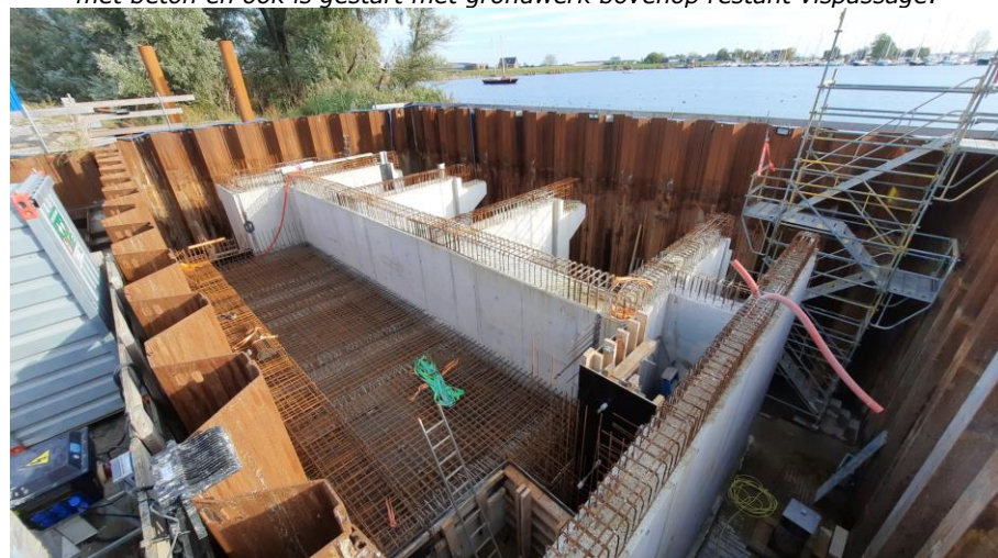
Foto 19: eind okt '22 wapening vloerdelen naar wegdeel is aangebracht
