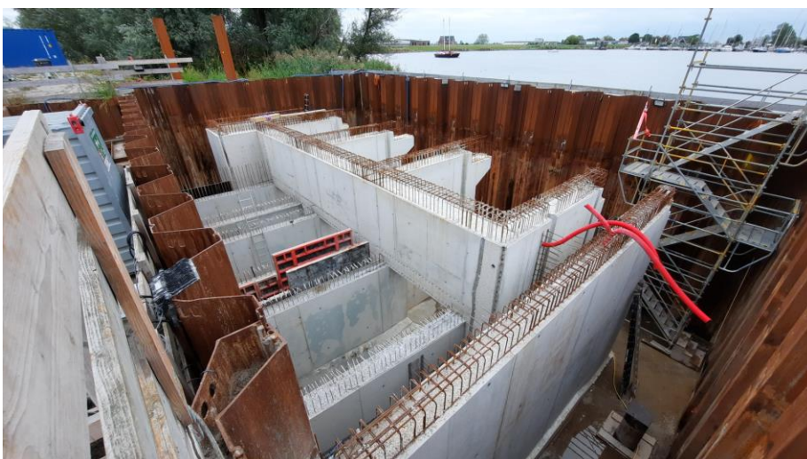
Foto 16: begin okt '22 tussenwanden naar wegdeel geplaatst
