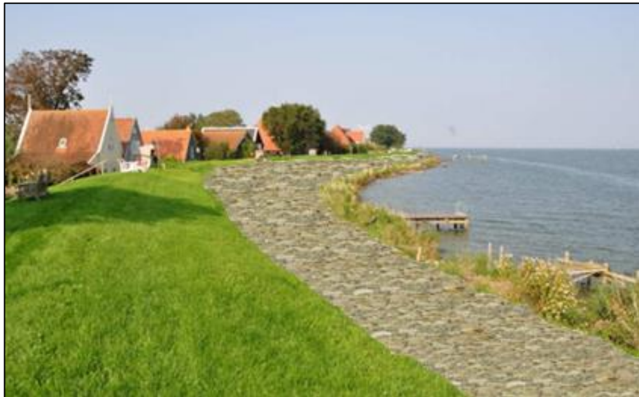
Artist impression van de bestaande dijk bij Uitdam Dorp, zonder begroeiing op de steenbekleding.
