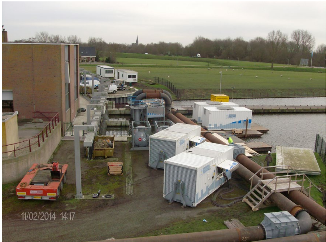
Figuur 30 Extra pomp die kan worden ingezet als tijdelijke vervanging van een bestaand gemaal. Het opbouwen duurt ongeveer een week
