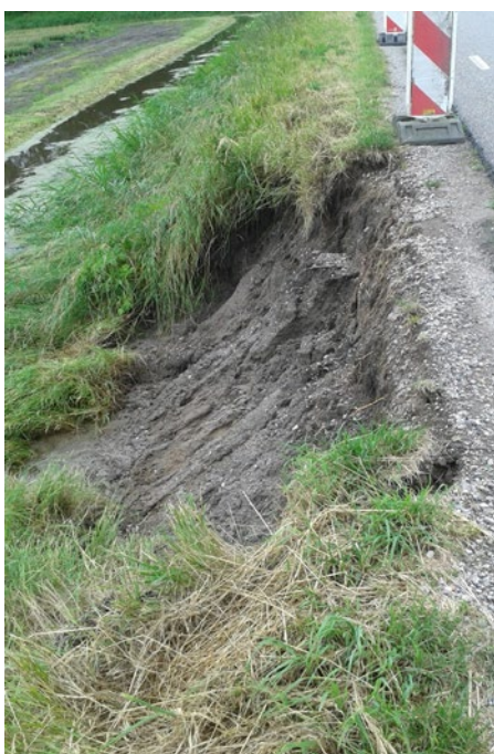
Figuur 36 Afschuiving aan de polderzijde langs de Grote Sloot nabij gemaal Zuider G.
